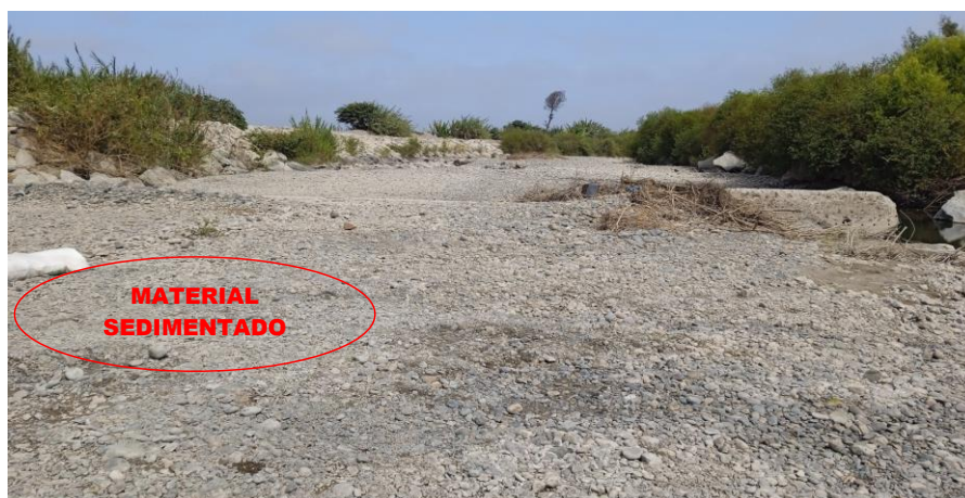
FIGURA N°02: MATERIAL COLMATADO EN EL CAUCE DEL RÍO HUARMEY, CON UNA PROFUNDIDAD PROMEDIO DE 1.0 M. ESTO PROVOCA QUE DESBORDAMIENTO DEL RÍO SEA MAS INMINENTE.
